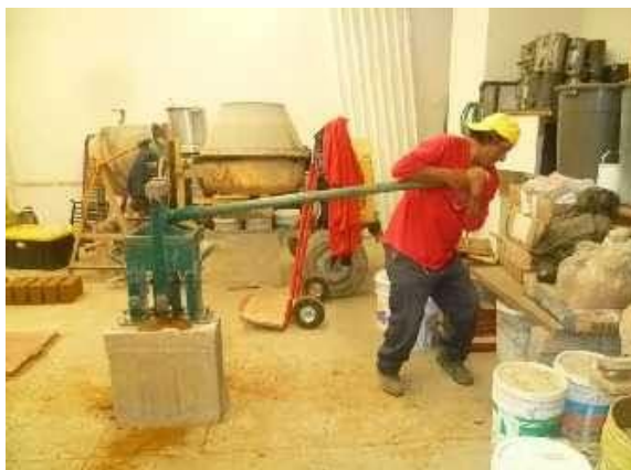
Figura 2. Compactación inicial del BTC.
