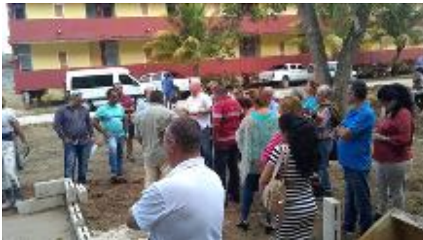
Figura 2. Inicio del proceso constructivo del polígono de instrucción. Visita de coordinación de empresarios del país a la UNICA para hacer precisiones sobre la construcción del polígono. Fuente: Autores
