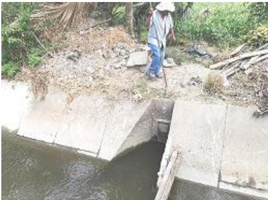
**Figura 3. Canal de sección trapecial y compuerta lateral.**
