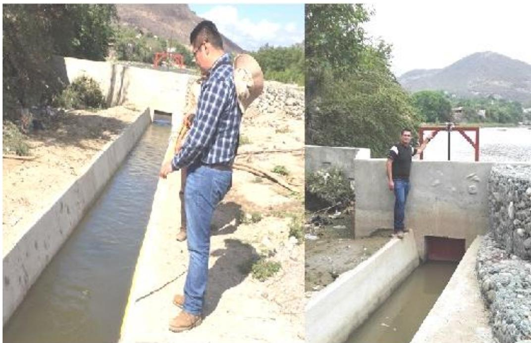
**Figura 2. Compuerta y canal rectangular para la derivación del agua.**
