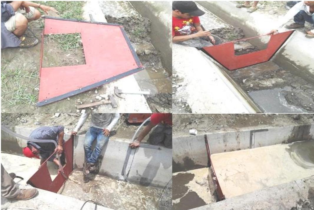
Figura 4. Proceso de instalación y prueba del vertedor en el canal de riego.
