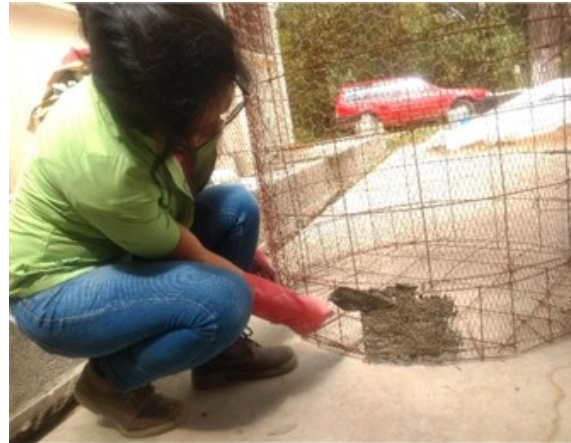
Figura 3. Proceso de aplicación manual de mortero
