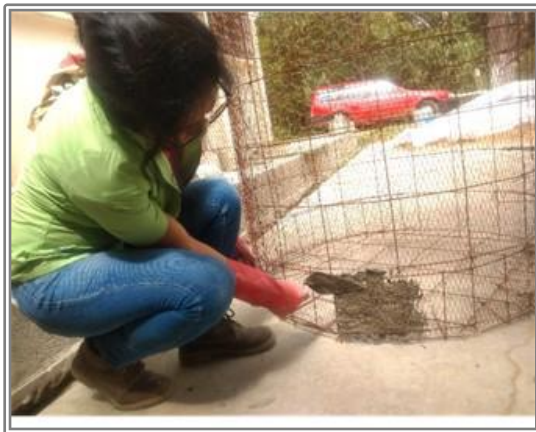
Figura 3. Proceso de aplicación manual de mortero
