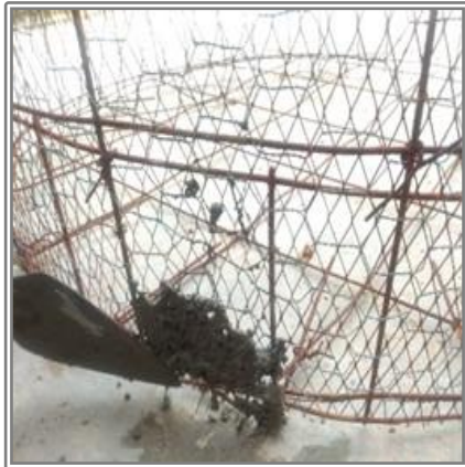
Figura 2. Detalle de la estructura de ferrocemento donde se realizaron las pruebas de embarrado.
