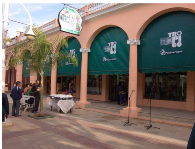
Figura 2. Tienda El Trópico recién realizado un mantenimiento planificado. Edificación con acceso a la cubierta a través de inmueble aledaño.
