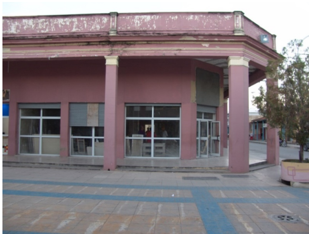
Figura 1. Tienda Boulevard en reconstrucción general. Edificación sin acceso a la cubierta.
