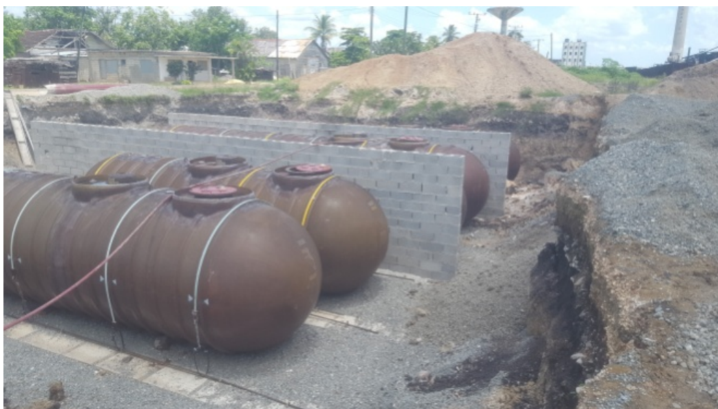
Figura 7. Construcción de paredes intermedias para soporte de la losa.
