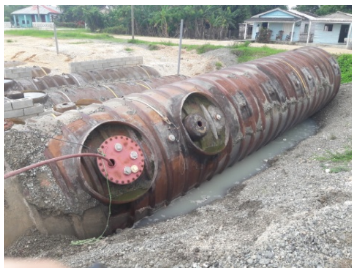
Figura 6. Levantamiento por flotación en el foso de tanques del SC Enrique Varona.
