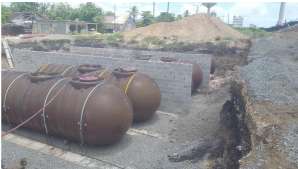
Figura 6. Construcción de paredes intermedias para soporte de la losa.
