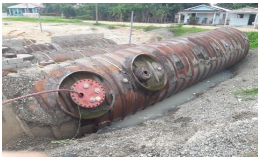
Figura 5. Levantamiento por flotación en el foso de tanques del SC Enrique Varona.
