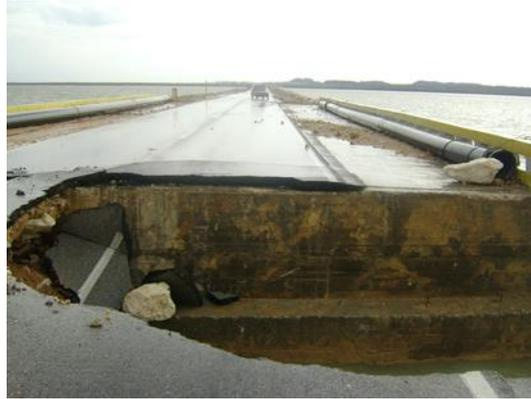
Fig. 1. Hundimiento del aprоче del puente
