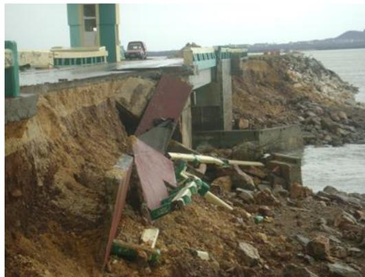
Fig. 2. Reducción de la sección del paseo
