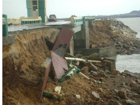
Fig. 1. Hundimiento del aprоче del puente
