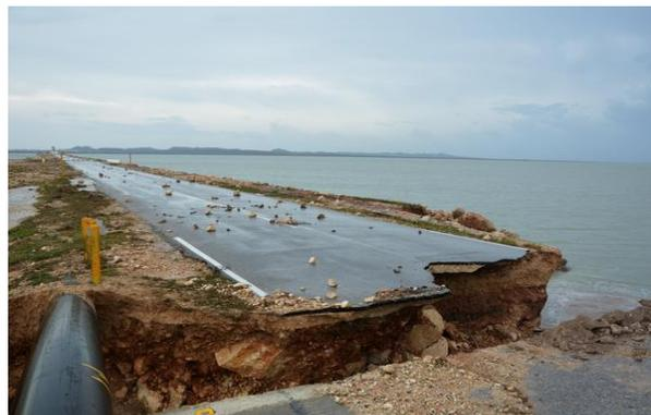
Fig. 3. Rocas de las escolleras sobre el pavimento
