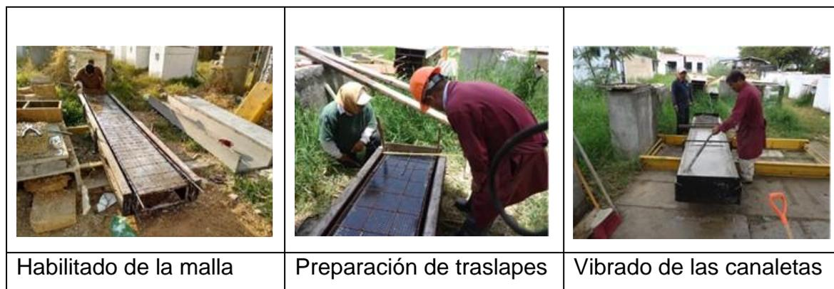
Figura 5. Proceso de elaboración del componente canaletas.
