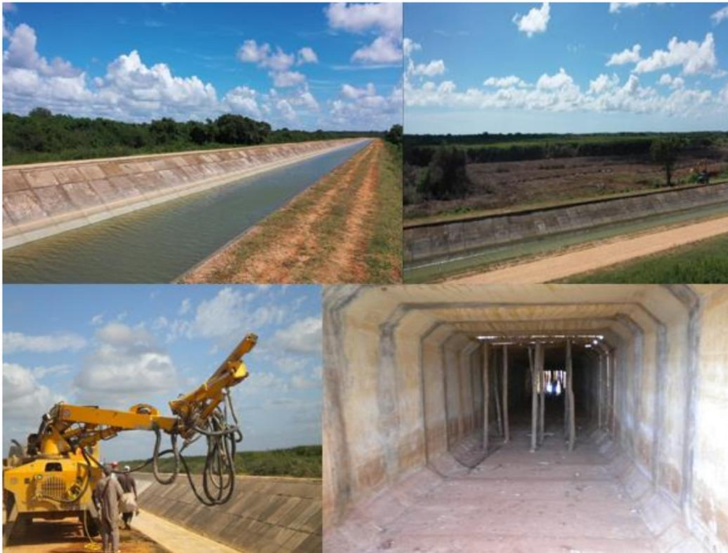
Figura 2. Vista de la seccion transversal, equipos de construcción y sifón invertido.
